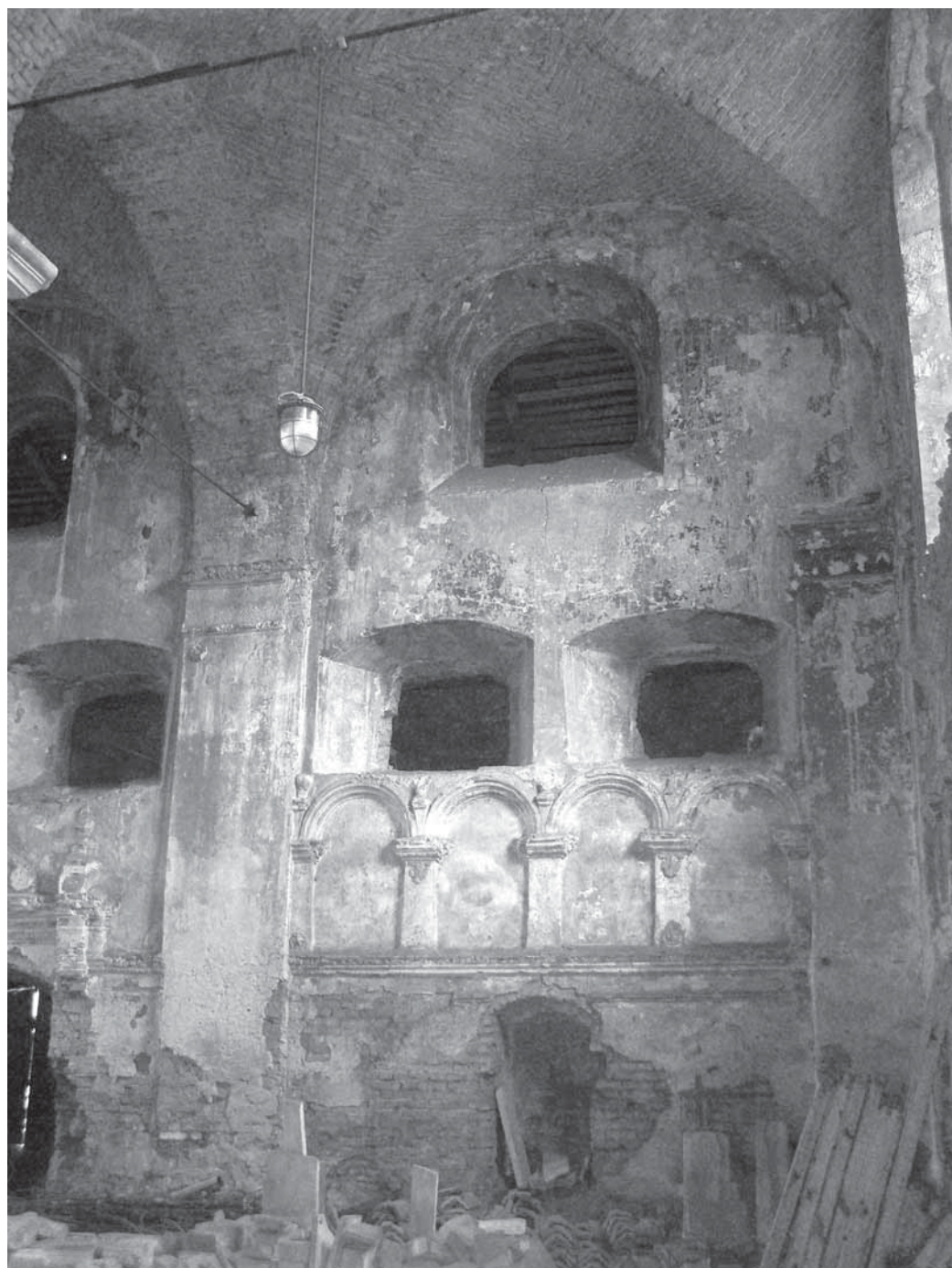
Рис. 35. Прорізи крайнього прясла західної стіни, осі яких не співпадають з віссю склепіння. Фото 2008 року
