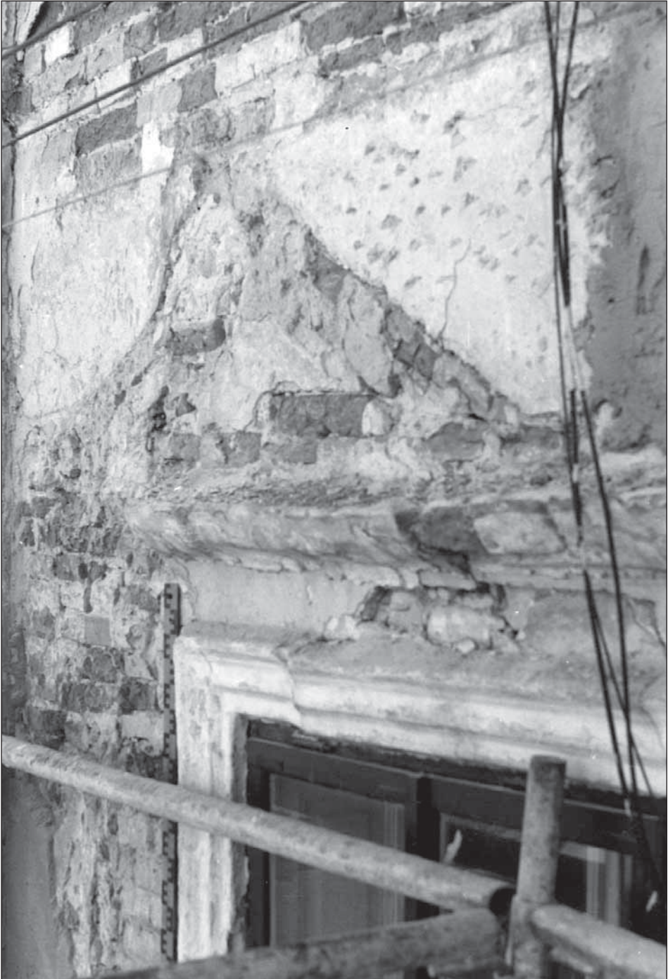
Рис. 2 Будинок на пл. Вічевій, 7 – вигляд на розкриті залишки трикутного сандрика на головному фасаді над віконним прорізом в рівні 2 поверху. Фото автора, 2000р.
