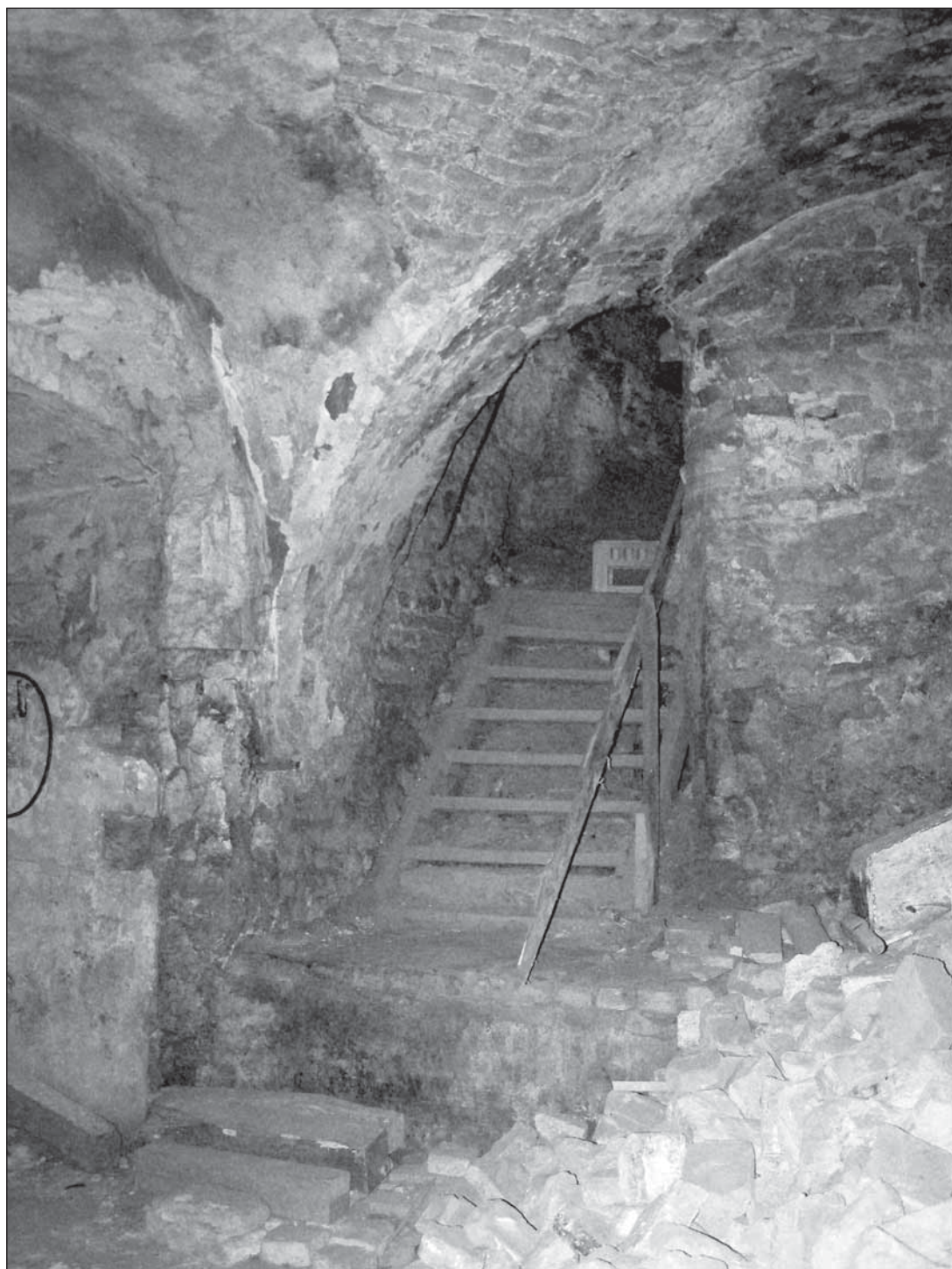
Рис. 38. Вихід на емпору в стіні західної синагогальної брили. Фото 2008 року
