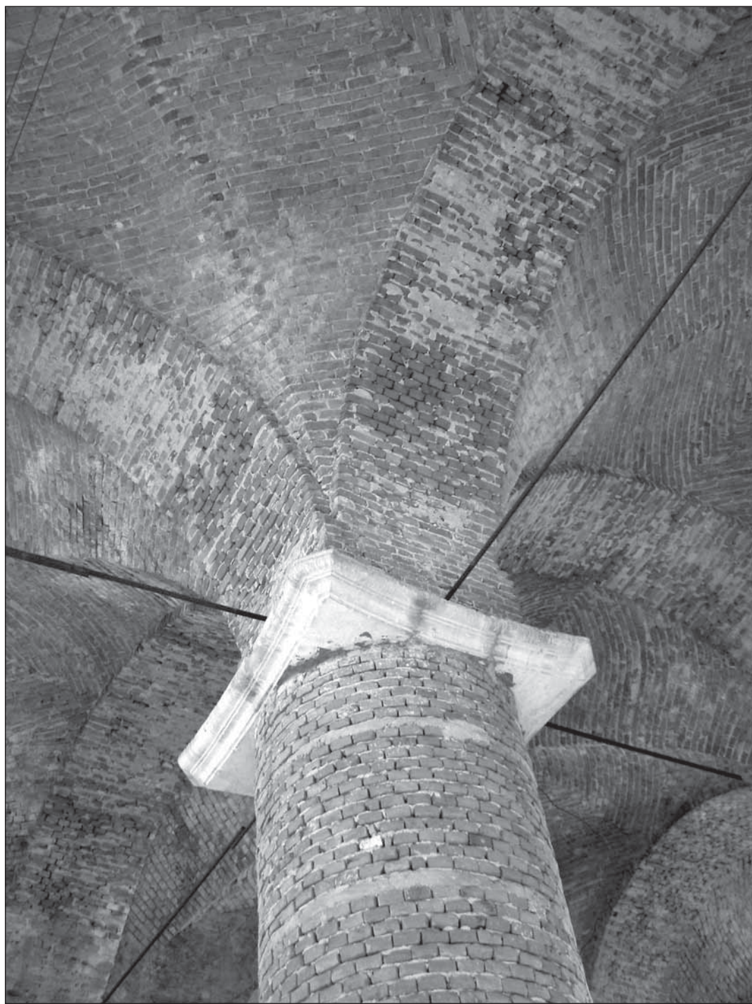
Рис. 40. Реконструйована у 1955- 1956 роках колона головного залу. Фото 2008 року
