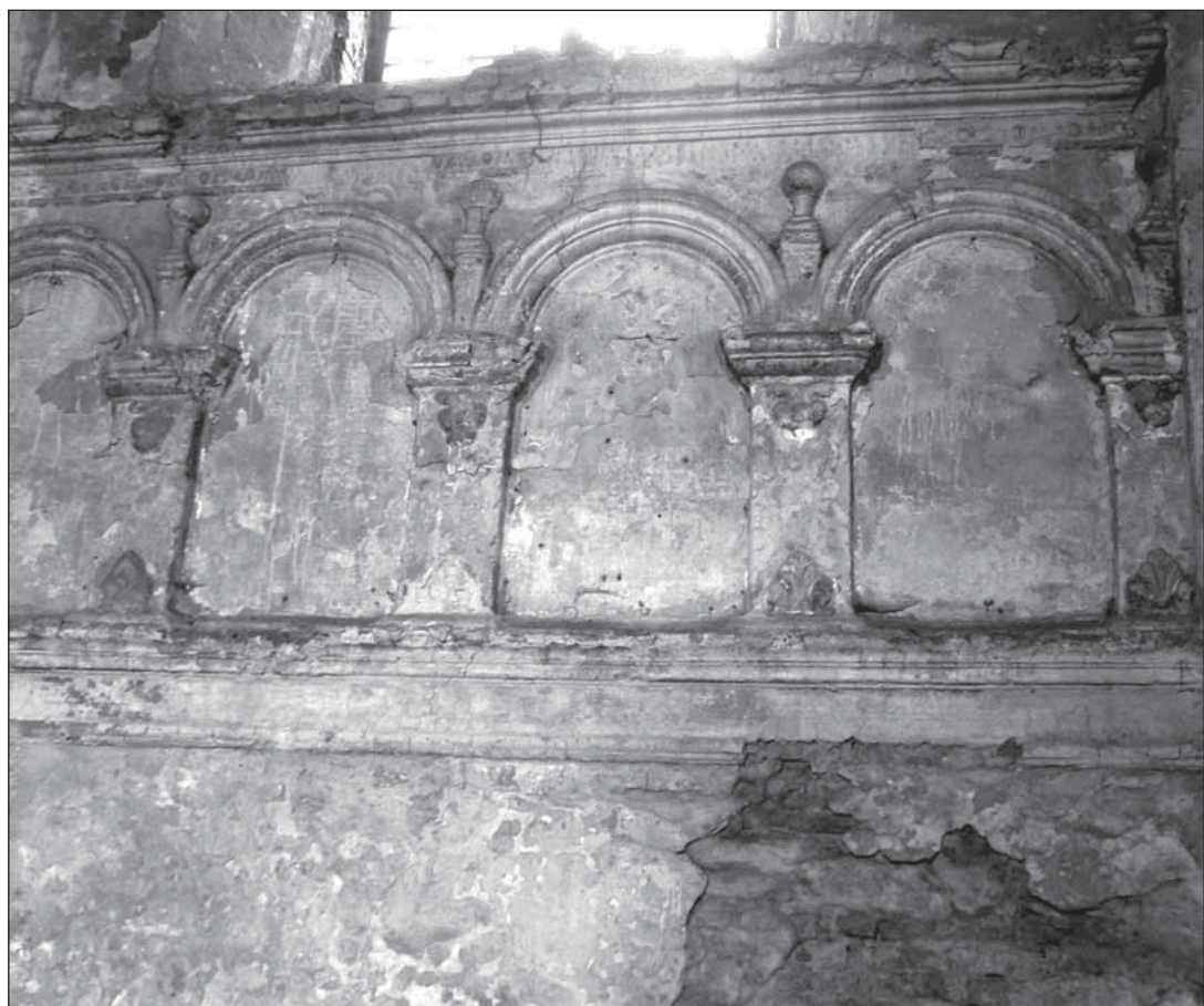
Рис. 32. Синагога в Жовкві. Фрагмент аркатурного поясу під вікнами молитовного залу. Фото 2008 року
