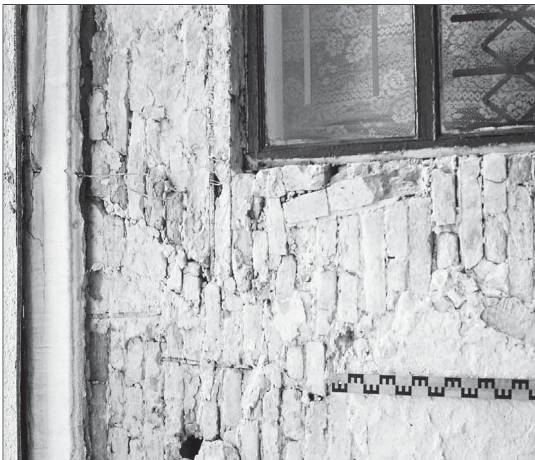
Рис. 5 Будинок на пл. Вічевій, 11 – вигляд на розкритті прорізу залишки мурування лучкової прорізу перемички XVIII ст.. Фото автора, 2000 р.
