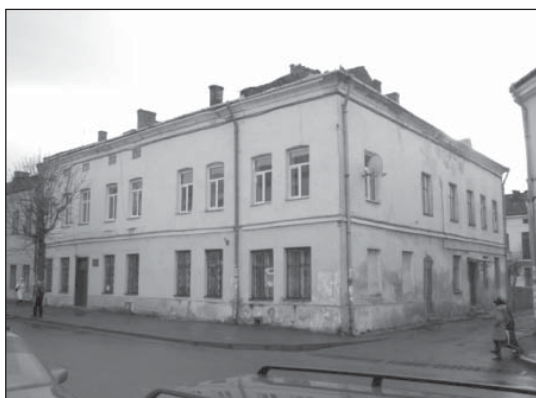
Нововиявлена пам'ятка архітектури – житловий будинок по вул. Львівській №12-14.
