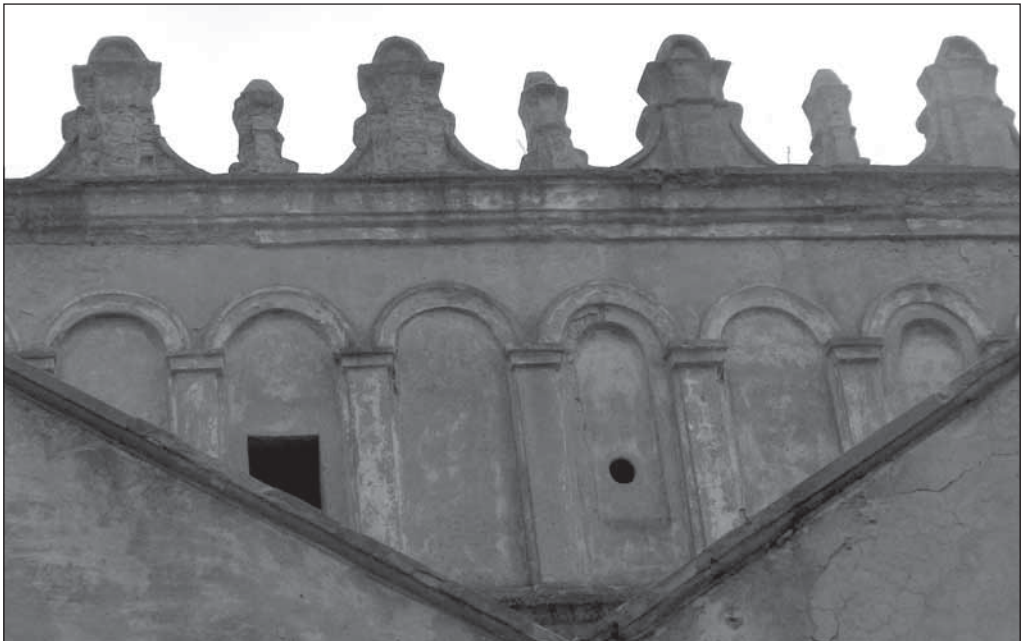
Рис. 42. Елементи синагоги, влаштовані під час реставрації 1830-х років. Фрагмент аттика над головною брилою, наріжний північно-східний контрфорс, портал головного входу. Фото 2008 року
