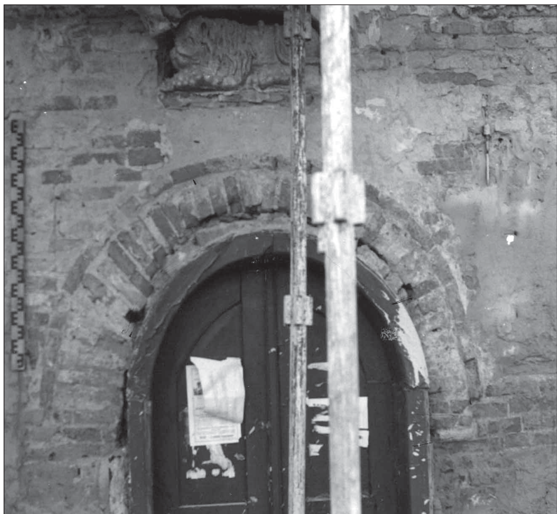
Рис.3 Будинок на пл. Вічевій, 9 – вигляд на розкритті залишки обрамлення центрального входу. Фото автора, 2000 р.
