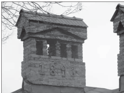
Буд. № 1 по вул. С.Бандери. Оголовок коміна. Фото 2009 р.
