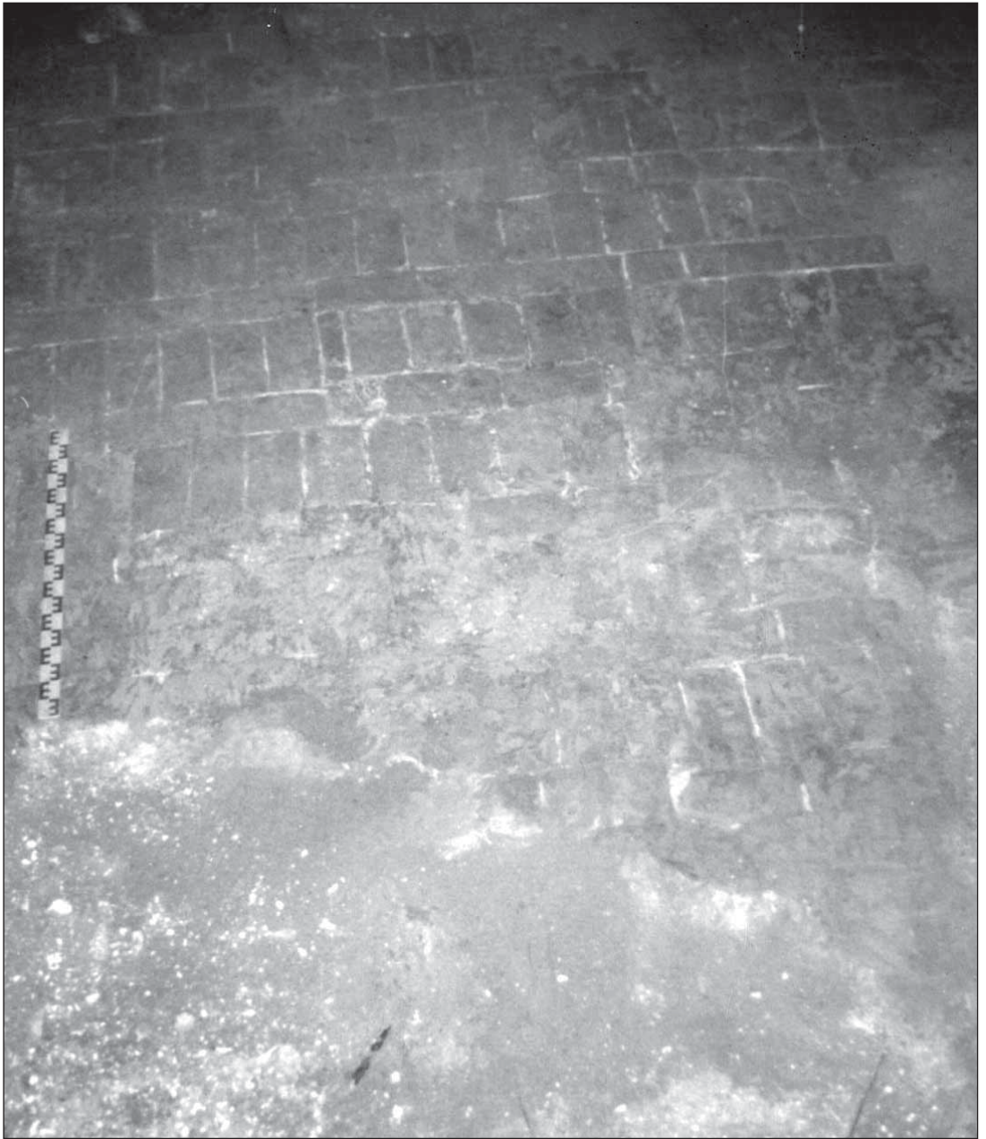
Рис.10 Будинок на пл. Вічевій, 15 – фіксація автентичної підлоги, викладеної цеглою в приміщенні на першому поверсі, розміщеного на захід від коридору-сіней. Фото В. Поповського, 1999р.
