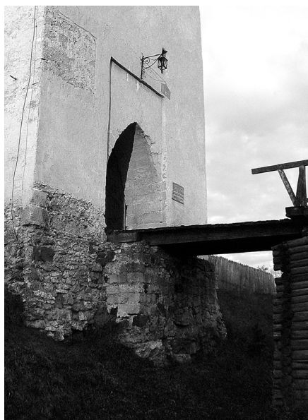
Рис. 9. П'ятничанська вежа. В'їзний вузол з підйомним мостом. Фото 2010 р. (схема №1)
