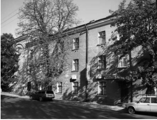
Південний фасад монастиря Домініканок. Фото 2010 р.
