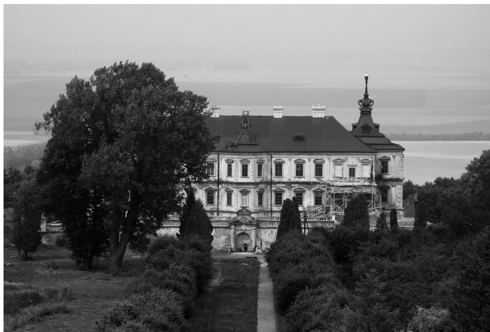
Il. 5. Pałac w Podhorcach, stan współczesny, fot. K. Czajkowski, 2004 r.
