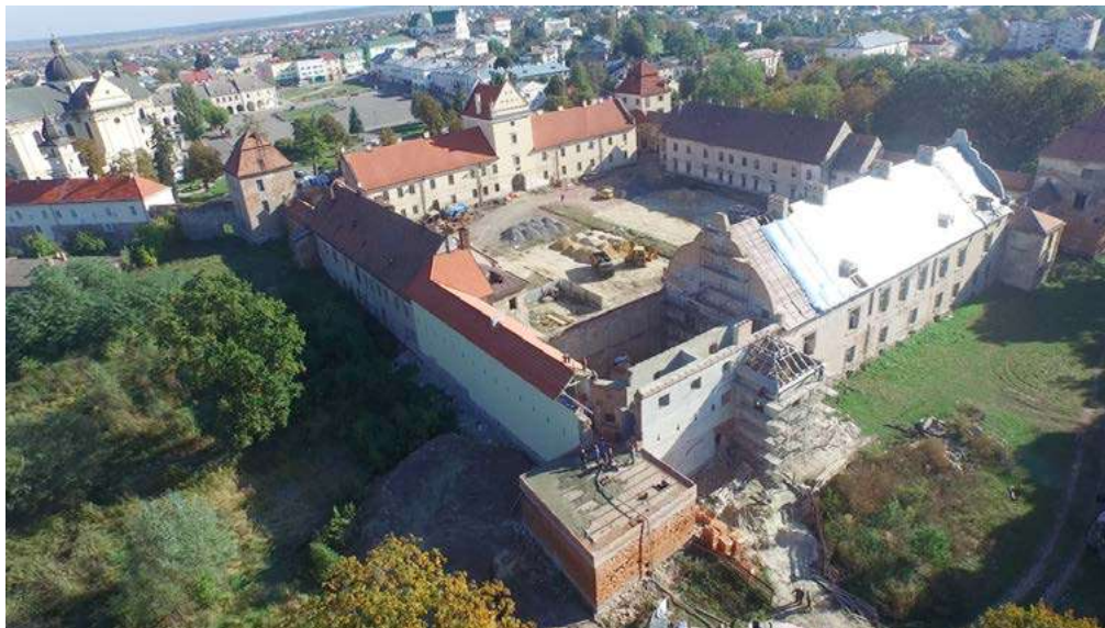
Іл.4.Реставраційно-відновлювальні роботи на замку, 2015 рік, фото з коптера.
