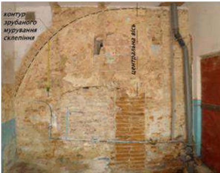
Іл. 23. Тильна стіна приміщення. Залишки мурування склепіння. Фото автора, 2016 р.
