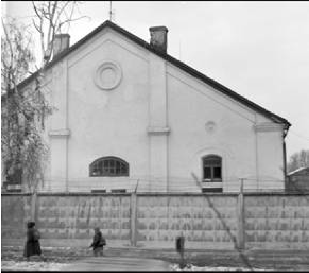
Лл. 6. Корпус механічного цеху заводу «Автомат». Головний (південний) фасад. Фото автора, 1993 р.
