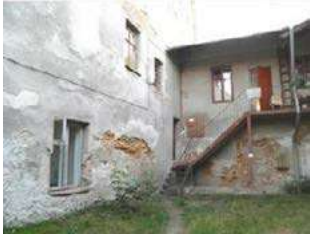
Іл. 26. Зондаж мурування межової стіни будинку на пл. Вічевій, 8 на ділянці саморозкриття мурування з боку подвір'я будинку на пл. Вічева, 9. Фото та графічна фіксація автора, 2016 р.
