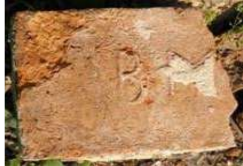
Іл. 14. Споруда історичного манежу. Таврована цегла, з якої споруджені муровані стіни споруди. Фото автора, 2020 р.
