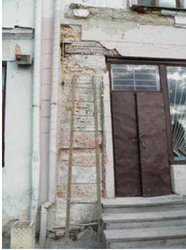
Пл. 25. Дослідження мурувань стіни головного фасаду пам'ятки. Зондаж №1–5. Фото та графічна фіксація автора, 2016 р.
