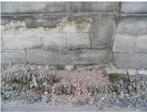
Іл.9. Споруда історичного манежу. Цокольна частина західного фасаду, виціліла ділянка прилеглого до споруди цегляного мощення вулиці (суч. вул. М. Шапкевича). Фото автора, 2020 р.
