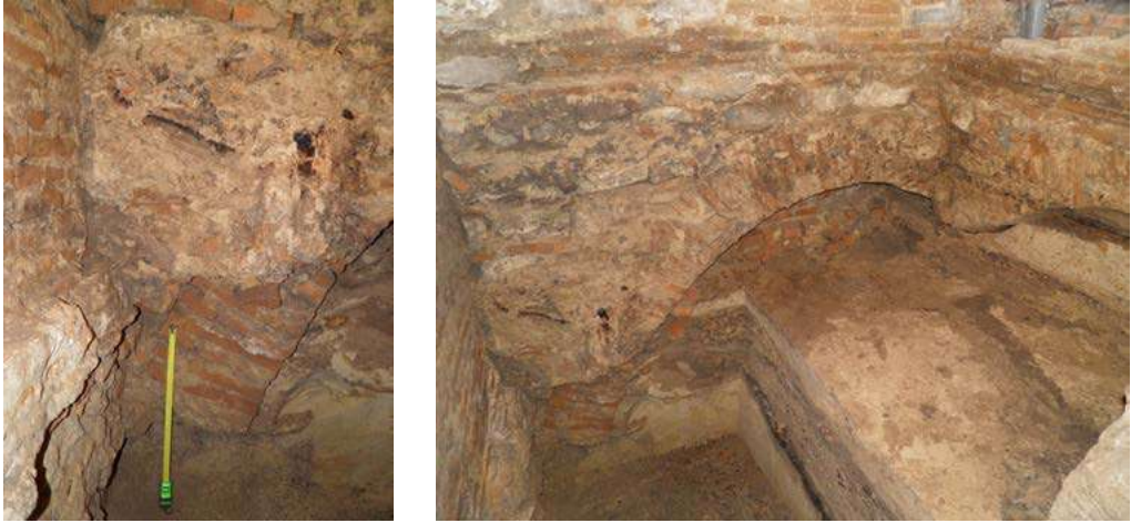
Лл. 20. Підпругна арка в основі тильної стіни приміщення. Фото автора, 2016 р.
