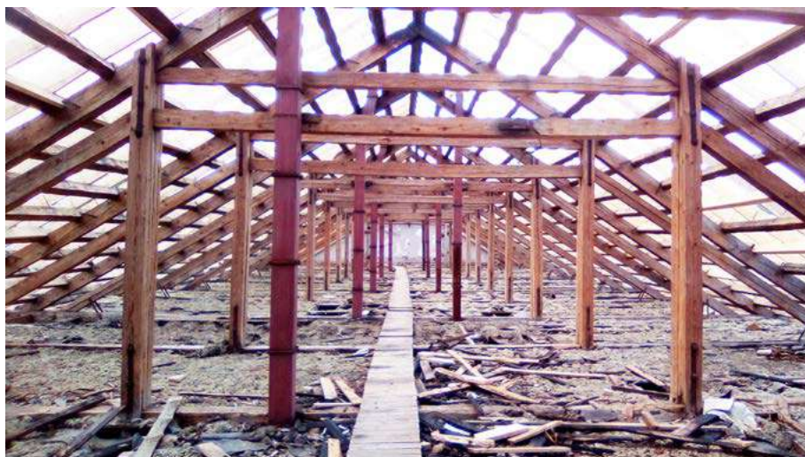
Іл. 16. Споруда історичного манежу. Дахові конструкції. Фото автора, 2020 р.
