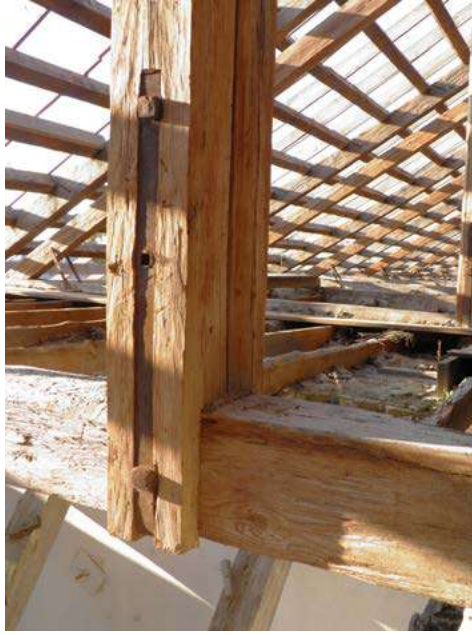
Іл. 18. Споруда історичного манежу. Дахові конструкції. Кроквяна ферма. Брус підвісної бабки закріплений до бруса зтяжки залізними хомутами і болтами. Фото автора, 2020 р.
