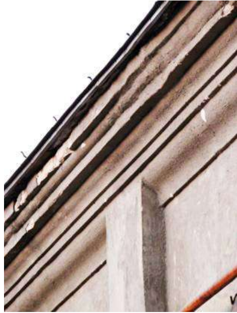
Іл.12. Споруда історичного манежу. Бічний західний фасад. Профільована тяга карнизу в піддашші. Фото автора, 2020 р
