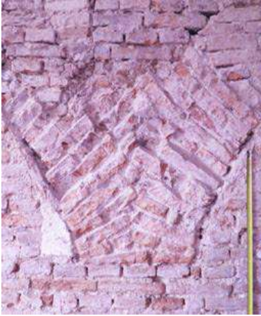
Іл. 22. Зрубані випуски мурування проміжної п'яти склепіння. Зондаж № 1–3. Фото і графічна фіксація автора, 2016 р.
